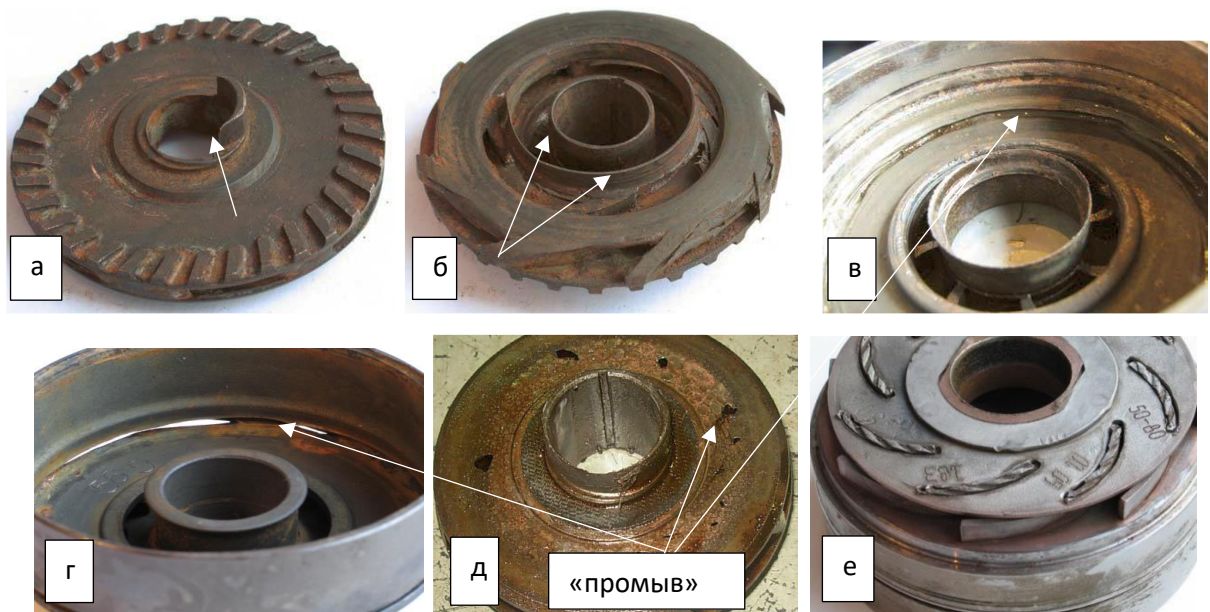
Рисунок 1.7 - Виды износа деталей ступени радиального типа (а - неравномерный износ радиального уплотнения, б - равномерный износ уплотнения, в, г, д, е - износ НА, е - фрагментация штамповарной конструкции)
